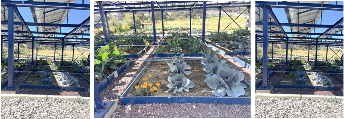
Figura 1: Efecto de luz y sombra proyectado por un arreglo fotovoltaico de 6 hileras, cada una con 12 MFV, espaciadas 1.45 m a una altura de 3.54 m
