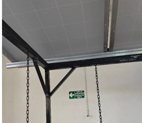
Figura 9. Soportes instalados en las esquinas superiores.
