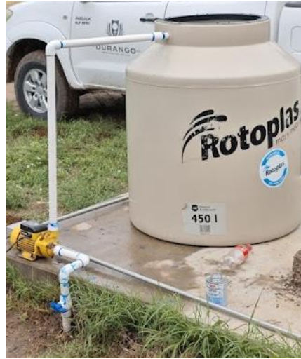
Figura 03. Cisterna para uso exclusivo del biodigestor.
