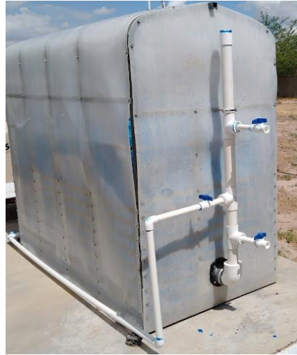
Figura 05. Sistema de recirculación.
