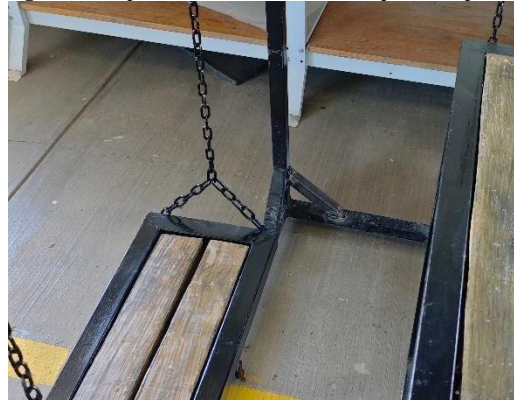
Figura 10. Soportes instalados en las esquinas inferiores.
