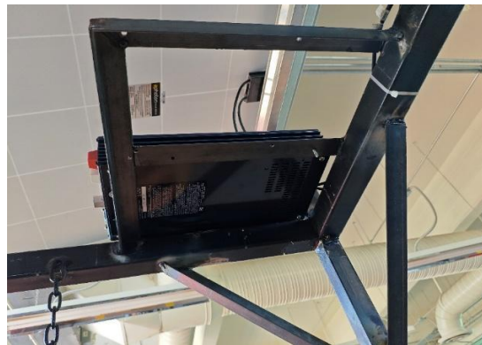
Figura 11. Soporte instalado en el techo para sostener el inversor, el controlador de carga y las baterías.
